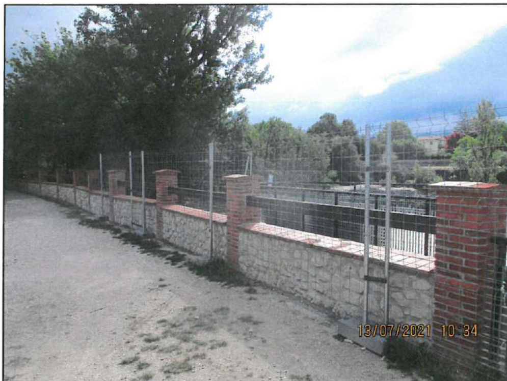
CERRAMIENTO EXTERIOR DE CANAL.
