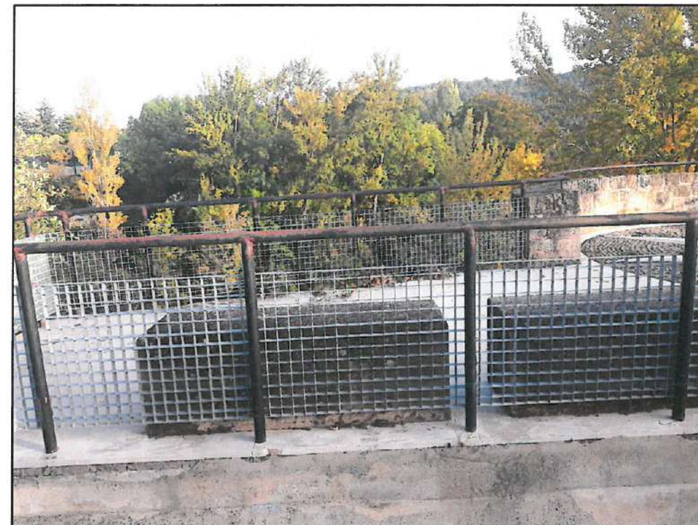
CERRAMIENTO INTERIOR DE CANAL.
