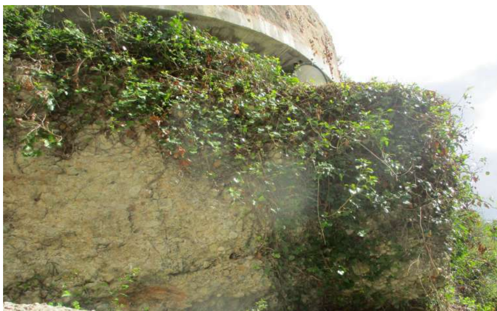
VISTA PARCIAL DEL APOYO DEL MIRADOR
