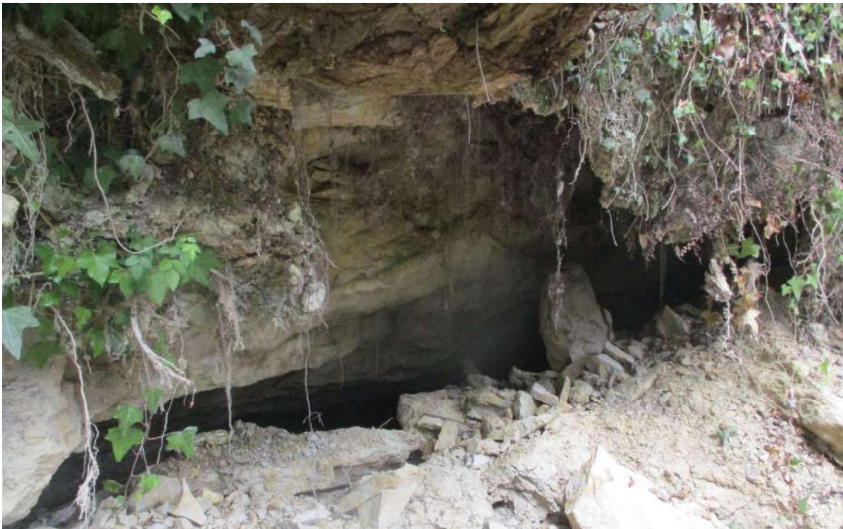
VISTA PARCIAL DE LOS DEPPRENDIMIENTOS Y DE HUECOS EN LA ROCA MADRE
