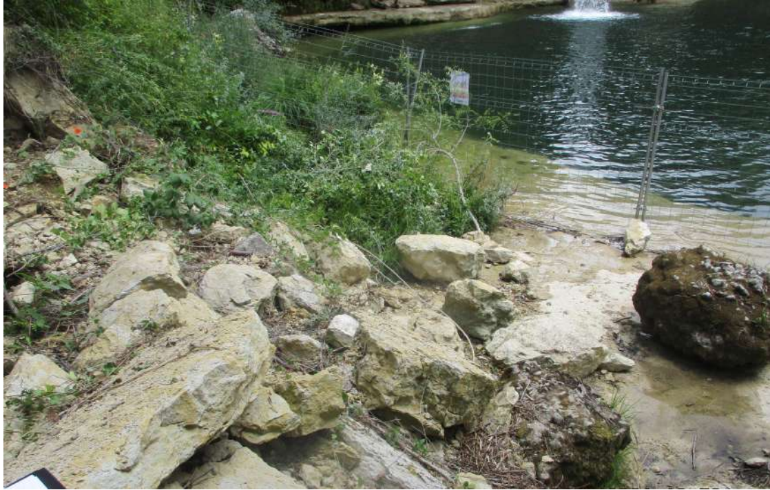
DETALLES ROCAS DESPRENDIDAS
