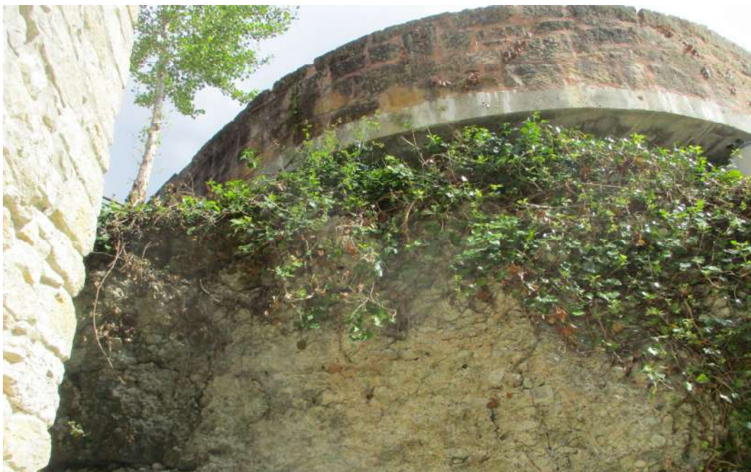
VISTA PARCIAL DEL APOYO DEL MIRADOR
