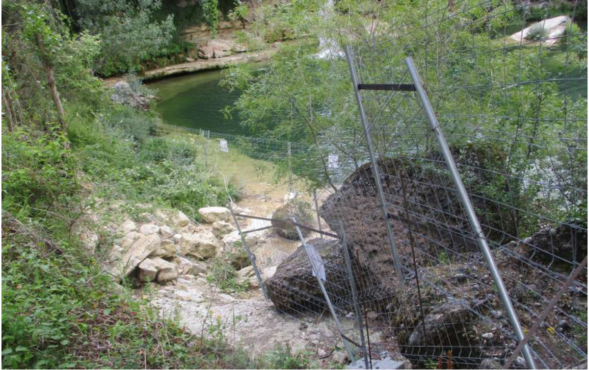
VISTA GENERAL ZONA DE DESPRENDIMIENTOS
