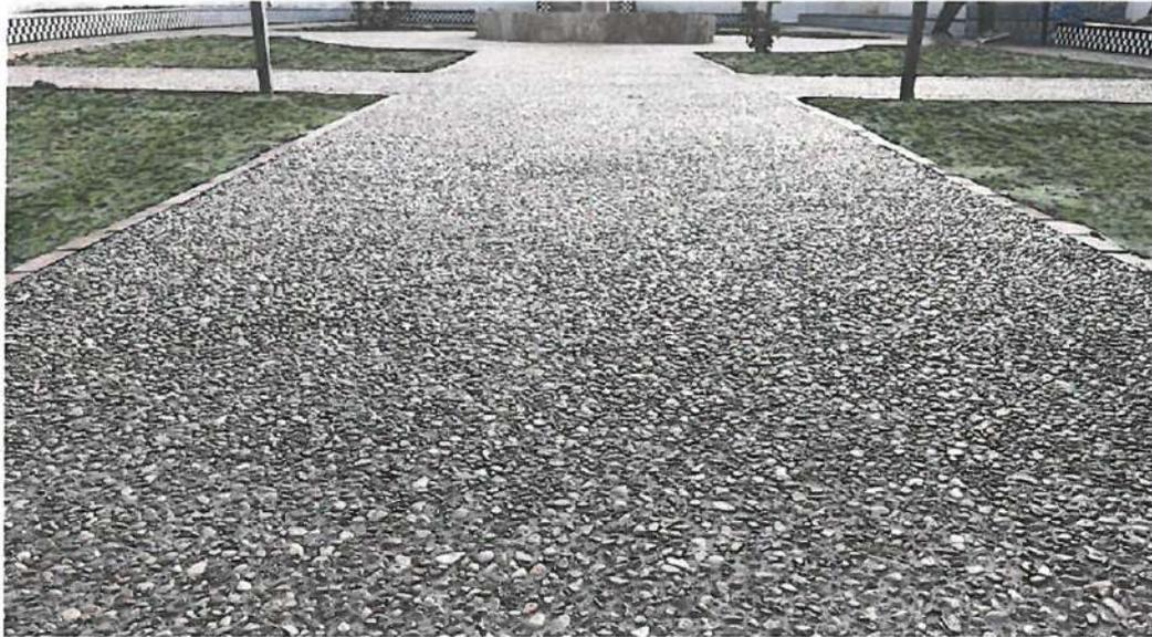
El espesor de la capa de hormigón será de 12 cms de espesor sobre capa de zahorra artificial de 20 cms de espesor.
